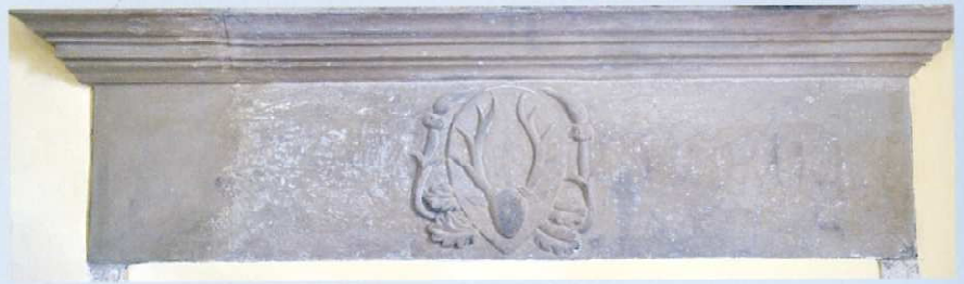
Camino all'interno del palazzo, nella sala della giustizia. Fireplace inside the palace, in the hall of justice.
